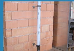
**Schritt 3:** Rohr kann zur provisorischen Wasserableitung schon montiert werden! Die montierten Schellen können für die Fassadenherstellung jederzeit wieder heraus gedreht werden.
