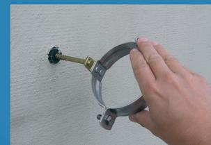
**Schritt 7:** Rohrschelle bis zum Widerstand in den Gummitteil stecken, dann eindrehen, Rohr montieren - FERTIG! (Sollte - in Ausnahmefällen - der Dorn zu locker sitzen, kann eine zusätzliche Fixierung mit üblicher Dicht-/Klebmasse erfolgen; ggfs. Probeklebung durchführen)
