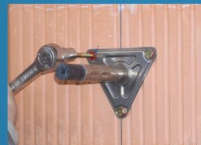
**Schritt 2:** Dübel nach Herstellervorschrift setzen. **Tipp:** Blitzdübel ideal für Beton und festes Mauerwerk, Rahmendübel bei porösem Untergrund.
