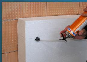
**Schritt 5:** Fassader klebt Dämmstoff und Fassade. **Tipp:** Raum zwischen Ausschnitt und Rohrschellenhalter einfach ausschäumen.
