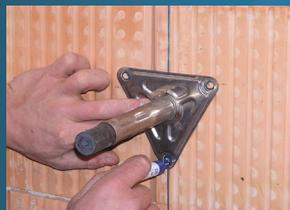
**Schritt 1:** Bohrlöcher markieren und bohren. Beim Bohren im Hohlblockziegel Schlag abschalten. **Tipp:** Dreiecksplatte für bessere Festigkeit mit der Spitze nach unten montieren!
