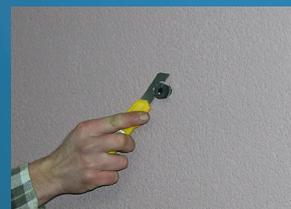
**Schritt 6:** Gummi entlang der Perforation kürzen. Fassadenoberfläche sollte vor dem Abschneiden ausgehärtet sein, um Schäden zu vermeiden, Gummi 3-5 mm aus der Fassade ragen lassen.
